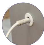
Zabezpieczone wyjście na kabel
